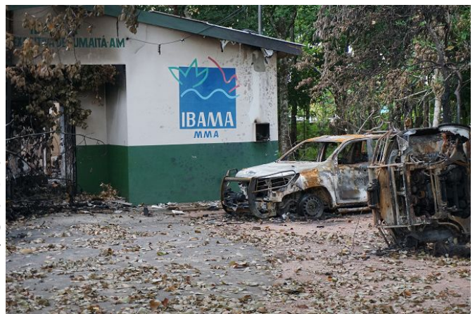
Ausgebranntes IBAMA-Gebäude und verbrannte Fahrzeuge in Humaitá, Bundesstaat Amazonas Foto: Putz
